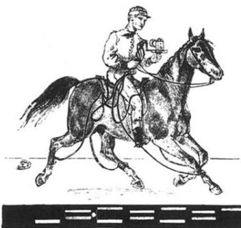
Koń z zamontowanymi czujnikami na czterech kończynach. Jeździec trzyma urządzenie zapisujące wyniki - rytm biegu. (Marey, 1873)
